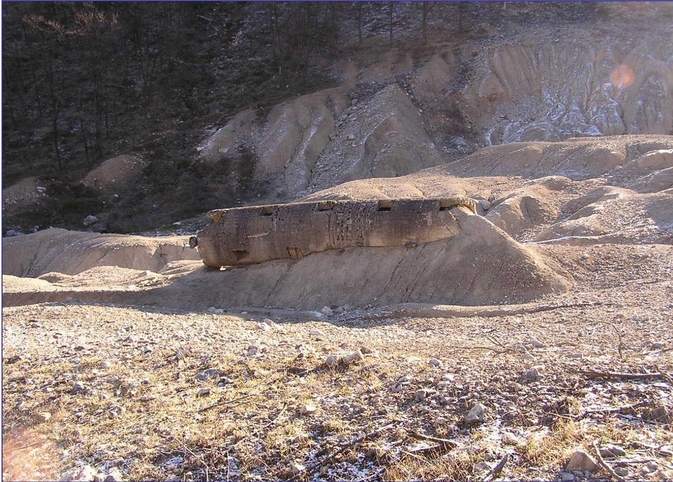
***I resti dell'argine della discarica per sterili di Sgorigrad in Bulgaria, al servizio di una miniera di zinco e piombo, che crollò il 1° maggio 1966 provocando la morte di centinaia di persone e ingentissimi danni ambientali.***
