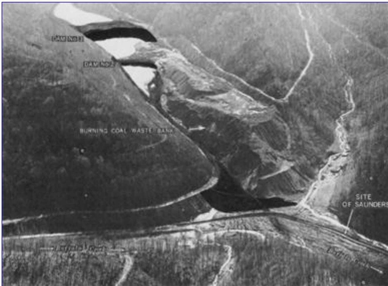
***Il disastro di Buffalo Creek, West Virginia (USA), 26 febbraio 1972. In seguito a piogge torrenziali si verificò la tracimazione dell'invaso superiore, al servizio di una miniera di carbone, che comportò il cedimento dell'argine: tutte le strutture a valle furono distrutte da una colata di oltre 500.000 m<sup>3</sup> di fango e detriti che causò la morte di 125 persone.***
